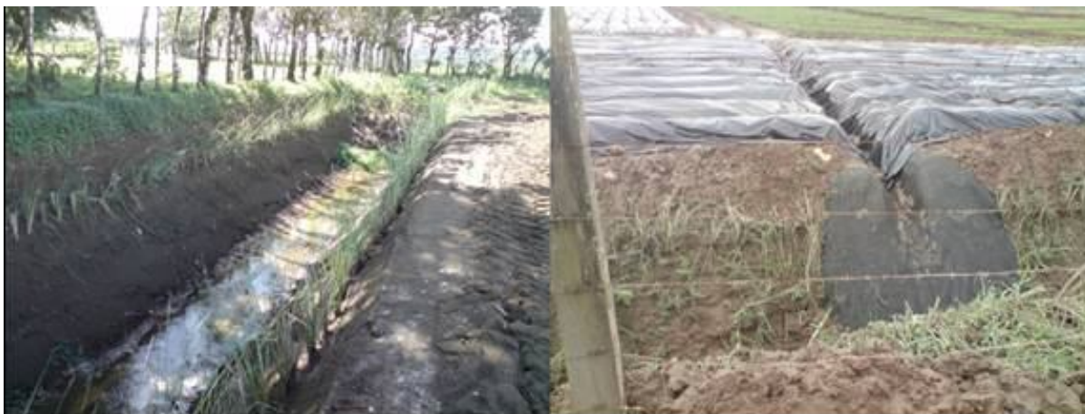
Figura 21. Control erosión: siembra de Vetiver en canales permanentes (izquierda), uso de geotextil en salida de cuaternario (derecha).
