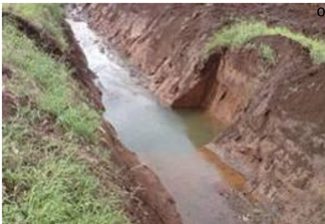
Figura 18. Recaba y sedimentador de canal recolector.
